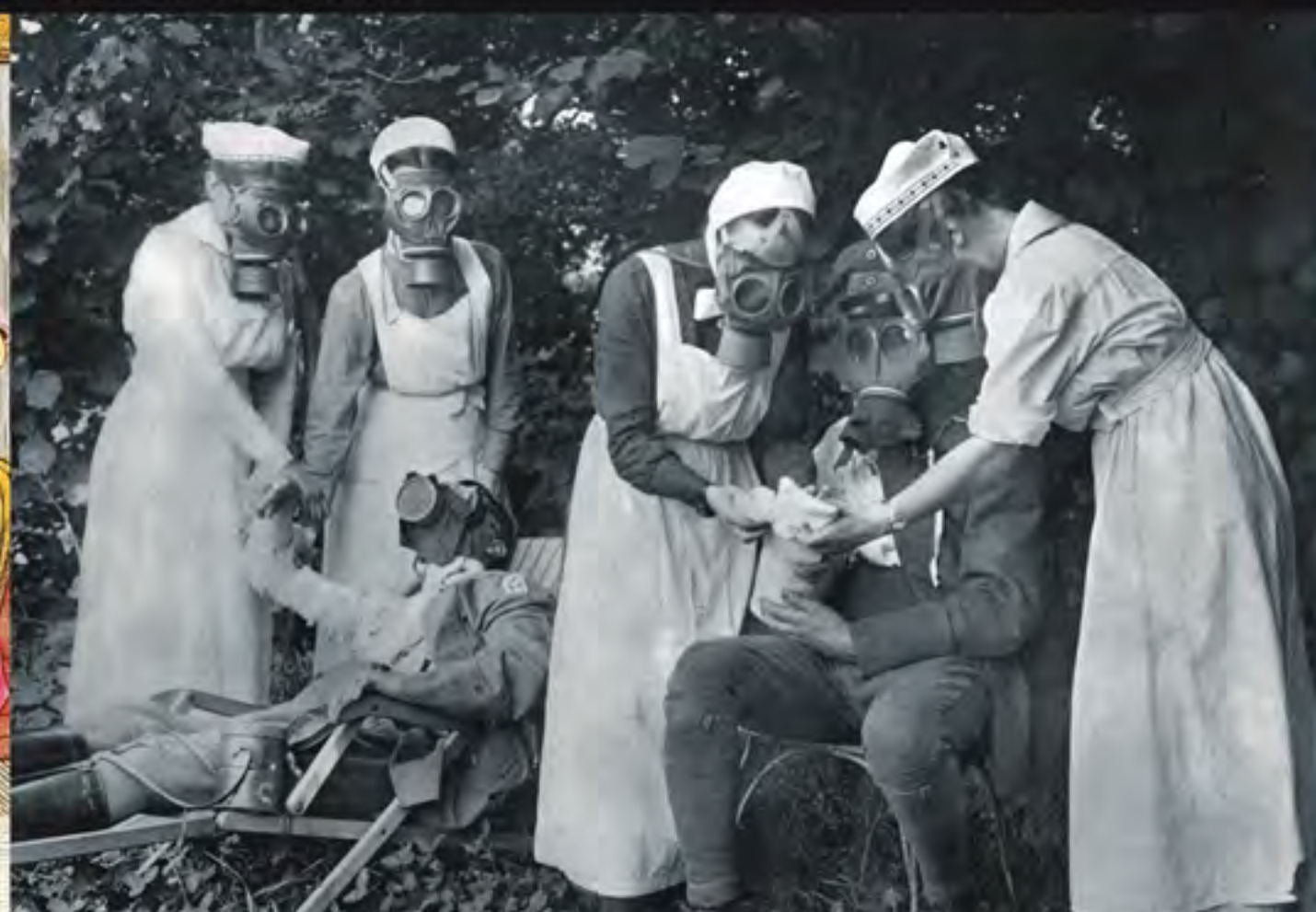
ERSTE HILFE NACH GASANGRIFF
